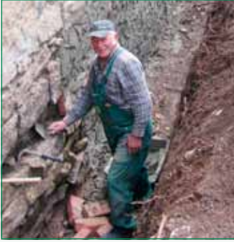
Mitarbeiter der Prüfer-Bau GmbH aus Andisleben beim Verputzen der Grundmauern
