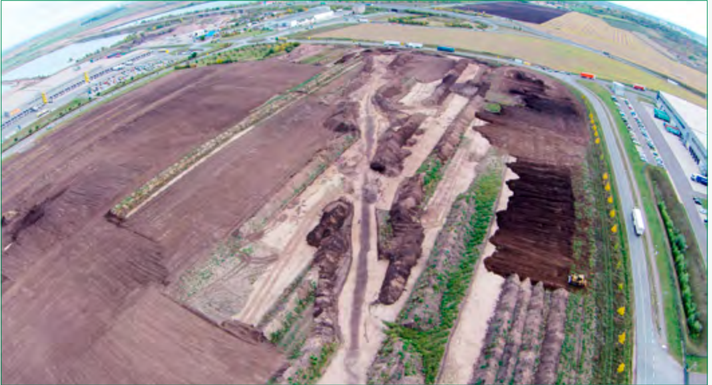
Bei den Ausgrabungen auf dem Schaeffler-Gelände kam ein gewaltiger Graben zum Vorschein. Er gibt Rätsel auf. Foto: Michael Jedamzik
