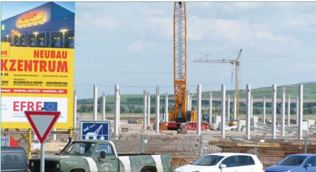
Das nächste Logistikzentrum ist bereits in Bau.
