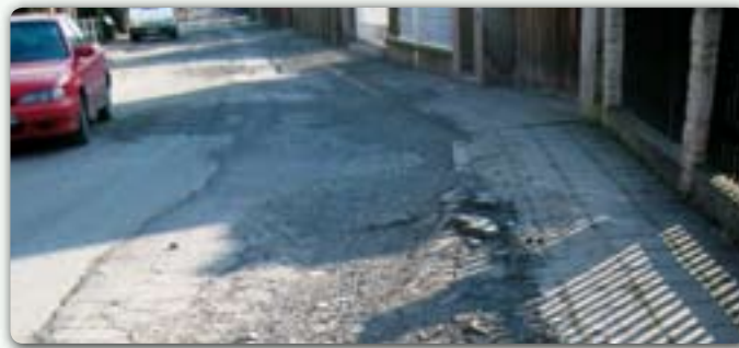
Auswirkungen des Umleitungsverkehrs in der Südstraße
