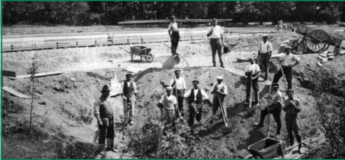
Musste 1988 aus der Ausstellung entfernt werden. Stotternheimer beim Bau des Freibads
